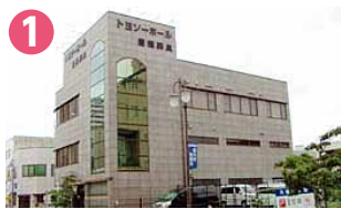
1 豊橋葬具 トヨソーホール 豊橋市魚町108
